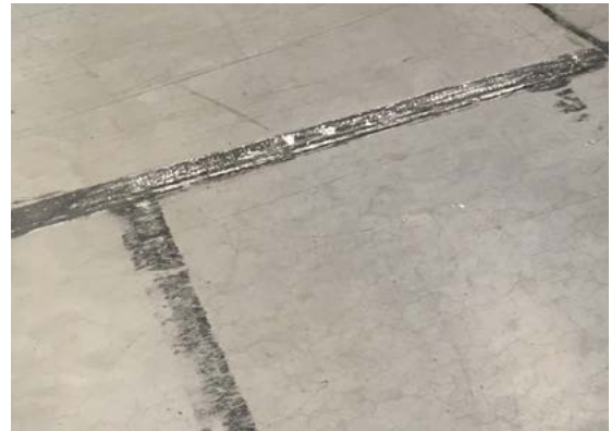
Abbildung 1: Abrieb an Bodenmarkierungen
